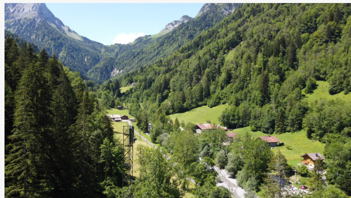
Site de couverture 4G multi-opérateurs de Thônes Montremont
