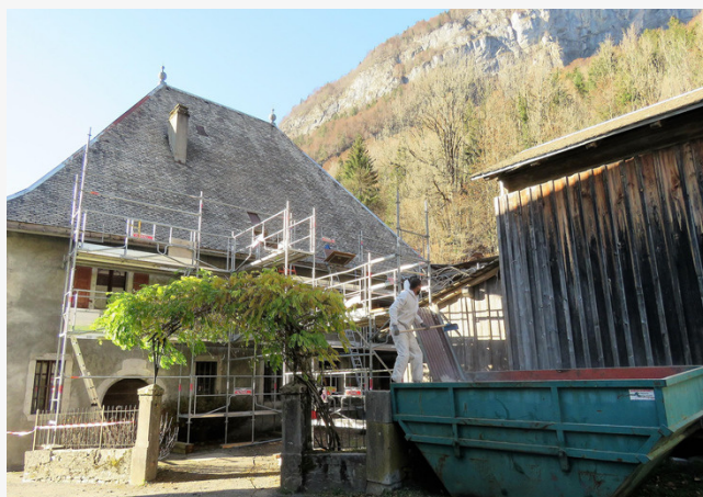
Travaux de rénovation de l'abbaye de Sixt-Fer à Cheval
